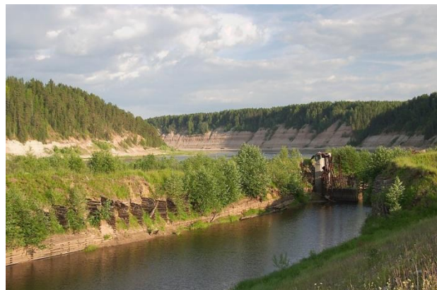
Рис. 20. Остатки Опоковского шлюза
